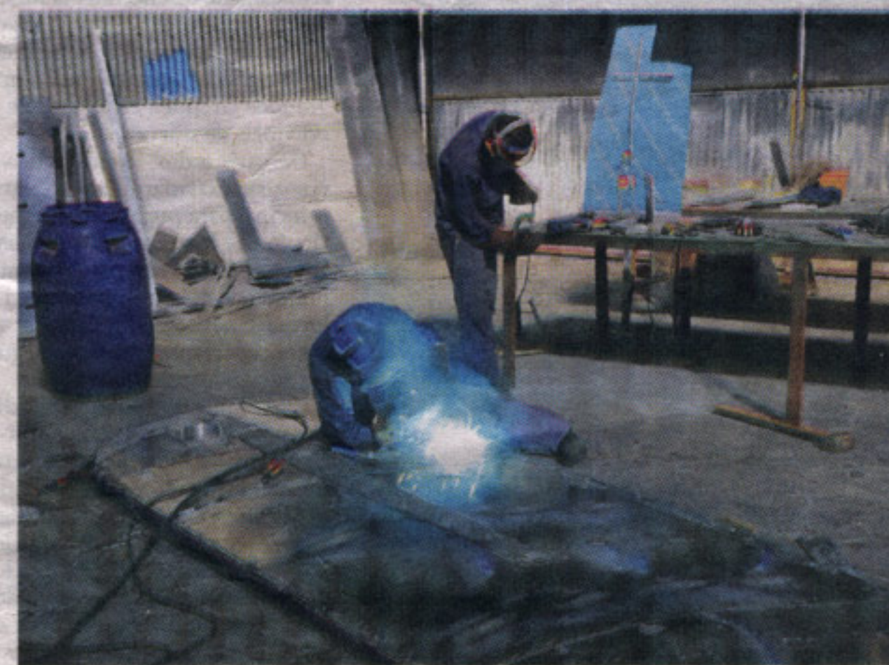
MANOS A LA OBRA. LOS HOMBRES SUELDAN LA ESTRUCTURA, QUE SERA DE ALUMINIO NAVAL.
